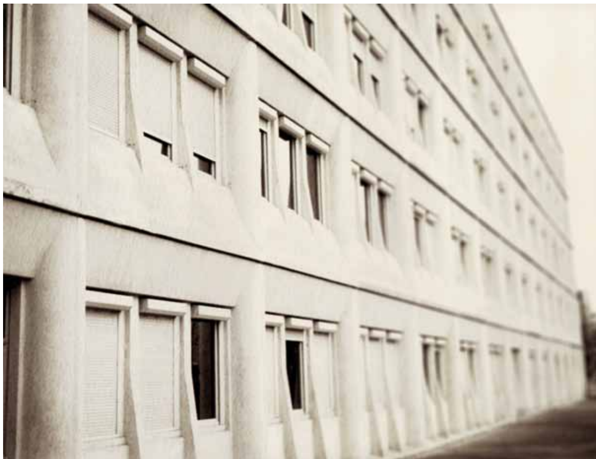
Façade du bâtiment P du CMC.
