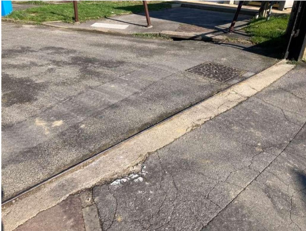
*Figure 37 : Irrégularité au sol dû au système coulissant du portail d'accès, un obstacle à franchir à vélo, octobre 2024.*
