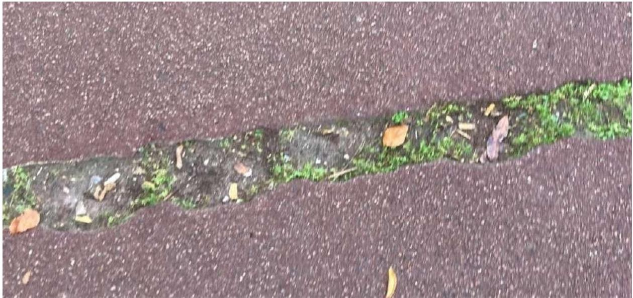
*Figure 16 : Large fissure du revêtement sur l'ensemble de la largeur du mail des Mèches, décembre 2024*
