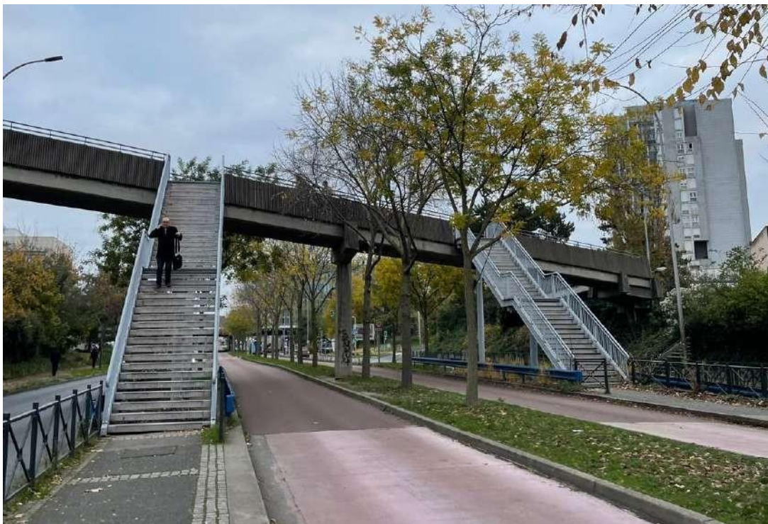
Figure 34 : Escaliers menant à la passerelle Jean Gabin vue de la voie TVM, novembre 2024 Source : Atelier vélo
